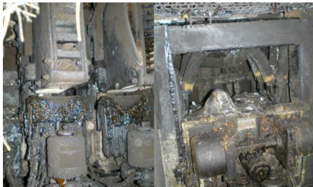
Fig.5. Contactori de linie MT3
